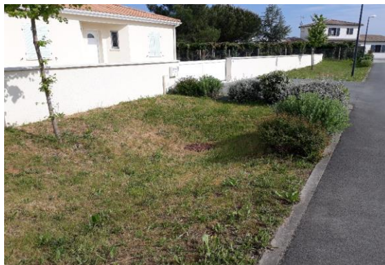
Figure 1 : Exemple de noue d'infiltration n°1
