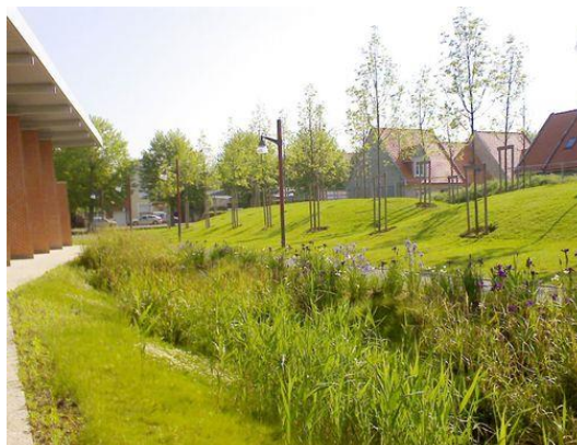
Figure 2 : Exemple de noue d'infiltration n°2
