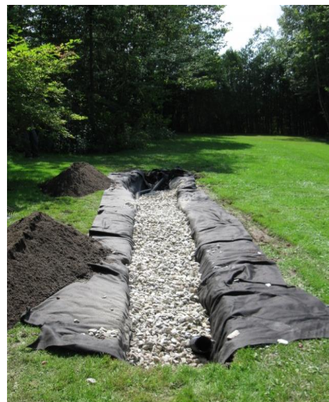
Figure 1 : Exemple de tranchée d'infiltration
